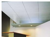
Plafones convencionales de aluminio, que proporcionan durabilidad, accesibilidad, facilidad de mantenimiento y control acústico.
