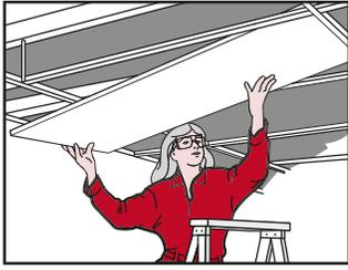
**Instalación de plafón acústico:** Antes de colocar las piezas de plafón, se deben de aclimatar con las cajas cerradas 48 hrs y se deben abrir los empaques 48 horas antes de su instalación para ventilar el producto y permitir su adaptación a las condiciones de humedad y temperatura del sitio.
