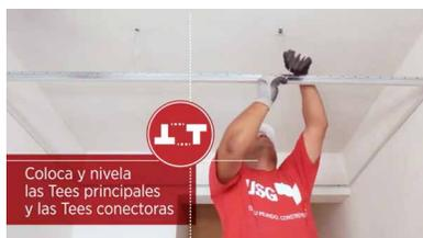
e) **Coloca el plafón Acústico USG RADAR™.** Antes de colocar las piezas de plafón acústico USG, se verifica el nivel horizontal de la suspensión y el encuadre, ajustando los colgantes o tees donde esto sea necesario. Ya ajustada y nivelada, se realizan los nudos definitivos dando tres vueltas y media a los cabos de los alambres, en un espacio no mayor a 2.5 cm. (1")
