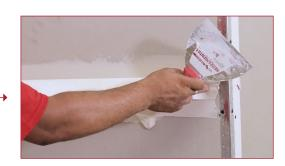
**3.** Cubre la cabeza de los tornillos con el Compuesto Multiuso para Juntas REDIMIX® en forma de cruz, retira el exceso y deja secar.
