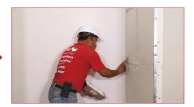
**2.** Coloca inmediatamente sobre el compuesto, la cinta de refuerzo USG PERFACINTA Marca TABLAROCA®; retira el exceso y asegúrate de que no queden burbujas debajo de la misma y deja secar.
