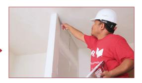
**4.** Una vez secas las juntas y las cabezas de los tornillos, aplica otra capa del Compuesto Multiuso para Juntas REDIMIX® hasta desvanecerlas con la ayuda de la espátula de 8" y deja secar.
