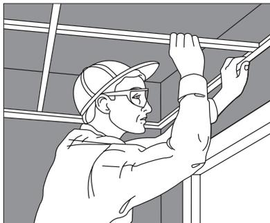
Les systèmes de suspension acoustiques (treillis) de CGC s'installent rapidement et facilement. Les panneaux acoustiques s'insèrent simplement dans le système de suspension.
