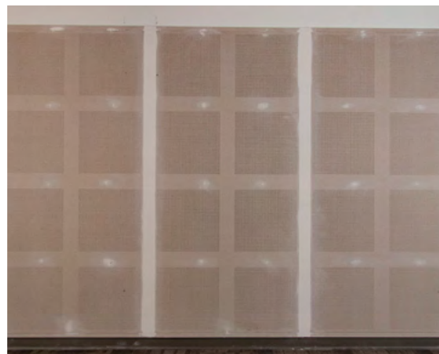
Troisième couche de composé à joints USGSheetrock MD appliquée.
