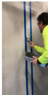
Application du composé à joints.
