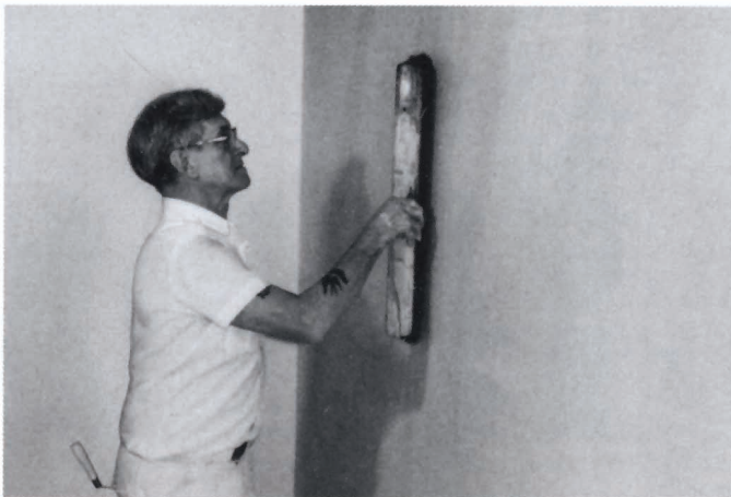
La surface de la couche de fond est laissée rugueuse et découverte pour l'application de la couche de finition.
