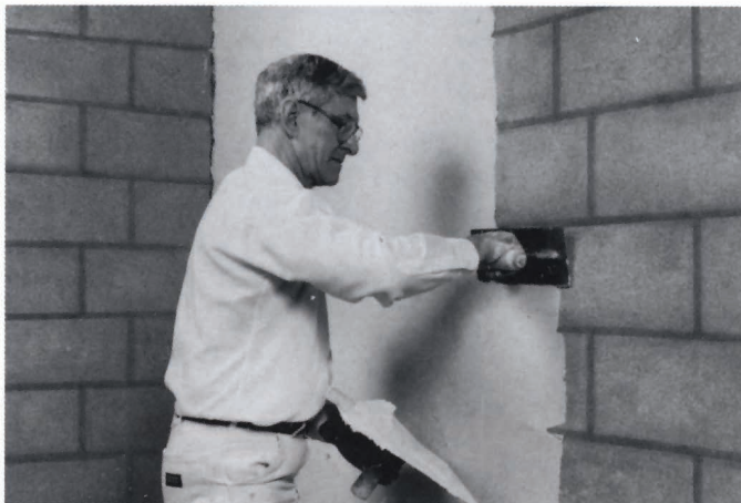
Application du plâtre mince de couche de fond DIAMOND sur maçonnerie ou béton monolithique traité avec un enduit.
