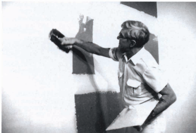
Application du plâtre mince de couche de fond DIAMOND sur la base de plâtre mince GRAND PRIX.
