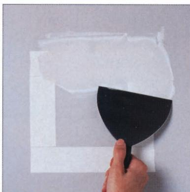
**4** Appliquer du ruban de papier ou en fibre de verre et du composé pour cloison sèche CGC sur la surface réparée. Les morceaux de ruban ne doivent pas se chevaucher. Appliquer une deuxième et une troisième couche de composé. Chaque couche doit être sèche avant qu'on applique la suivante; on doit amincir les couches sur leurs bords. Poncer, apprêter et peindre après le séchage.
