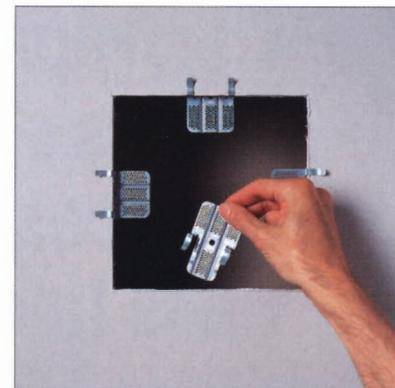
**2** Glisser les agrafes sur le bord de la cloison endommagée. Placer les vis à environ 3/4 po du bord et les centrer. On aligne ainsi les vis avec les perforations des agrafes. Visser dans le mur, dans chaque agrafe.
