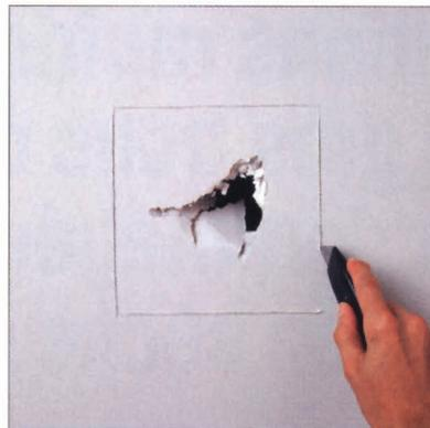
**1** Couper un morceau de cloison sèche aux dimensions de la partie du mur à réparer. Appliquer ce morceau sur le mur et tracer son pourtour au crayon. Découper soigneusement le long du trait de crayon et enlever la partie endommagée de la cloison sèche.
