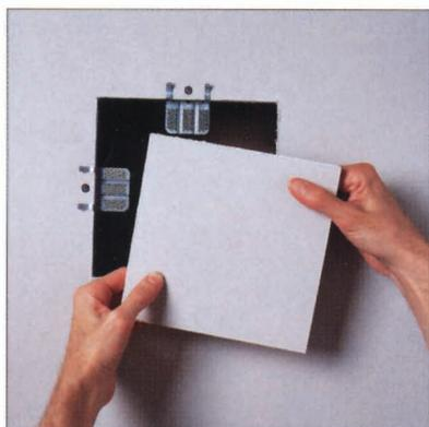
**3** Monter les vis dans la nouvelle section de panneau de gypse et dans chaque agrafe de réparation, à environ 3/4 po du bord. Enlever les pattes de chaque agrafe.
