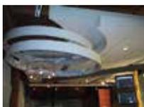
Molduras metálicas que permiten la creación de islas o huecos de formas libres para plafones, que incorporan cualquier suspensión convencional marca **USG DONN®** y plafones **USG** para interiores.
