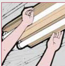
Instale todas las lámparas y alambrado para iluminación antes de colocar la loseta. Cuelgue las cajas para lámparas fluorescentes de algún elemento estructural firme y resistente. La retícula no está diseñada para soportar el peso de las lámparas.
